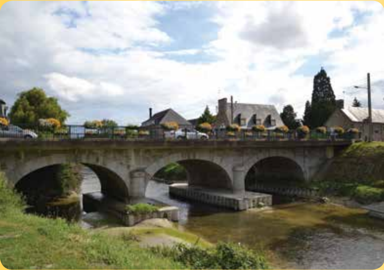
Pont de Pontorson
